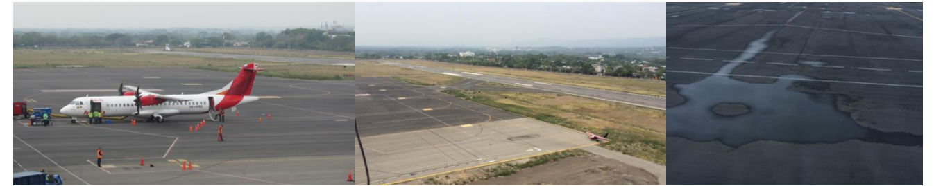
Imagen 2.2. Estado actual de plataforma Fuente. Elaboración propia
