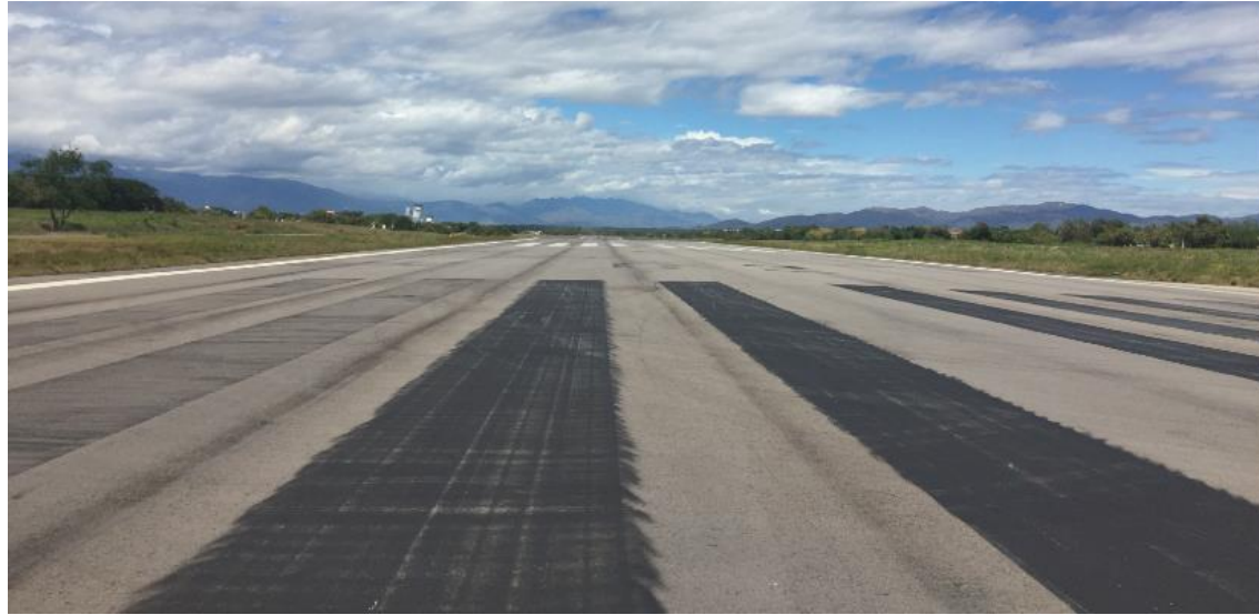
Imagen 2.14. Vista de las condiciones superficiales de pista desde cabecera 20.
